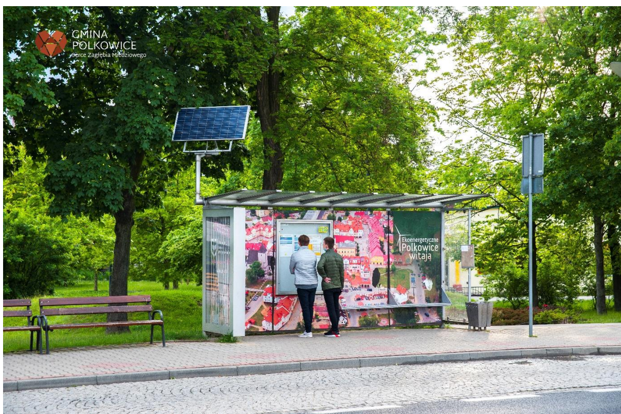
Rysunek 10 Wiata z panelami fotowoltaicznymi w Polkowicach
